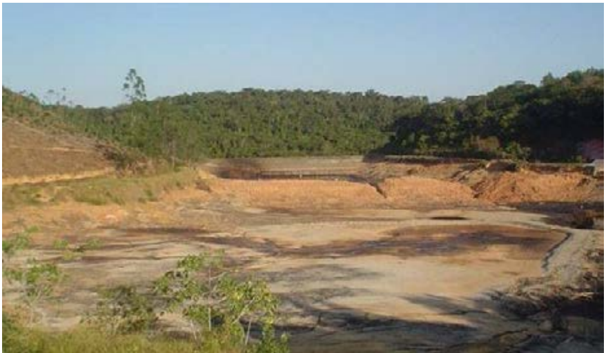
Imagem [37]. Depois do acidente, as barragens foram esvaziadas. Foto de 05.08.2010 (Cata-guases de Papel/Arquivo Pessoal).
